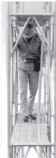
伸縮梯子が設置されていても、作業床上で支障なく、水平移動が行えます。
